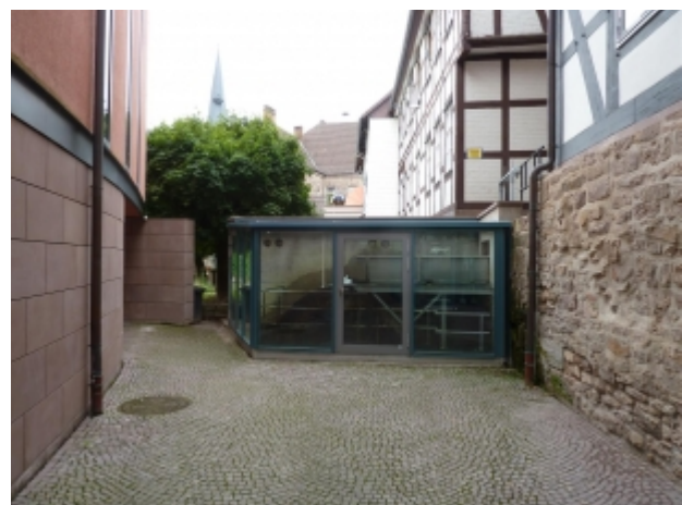
Wasserrad zur Stromerzeugung am Alten Rathaus Uslar
