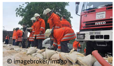
Schutzwälle aus Sandsäcken
