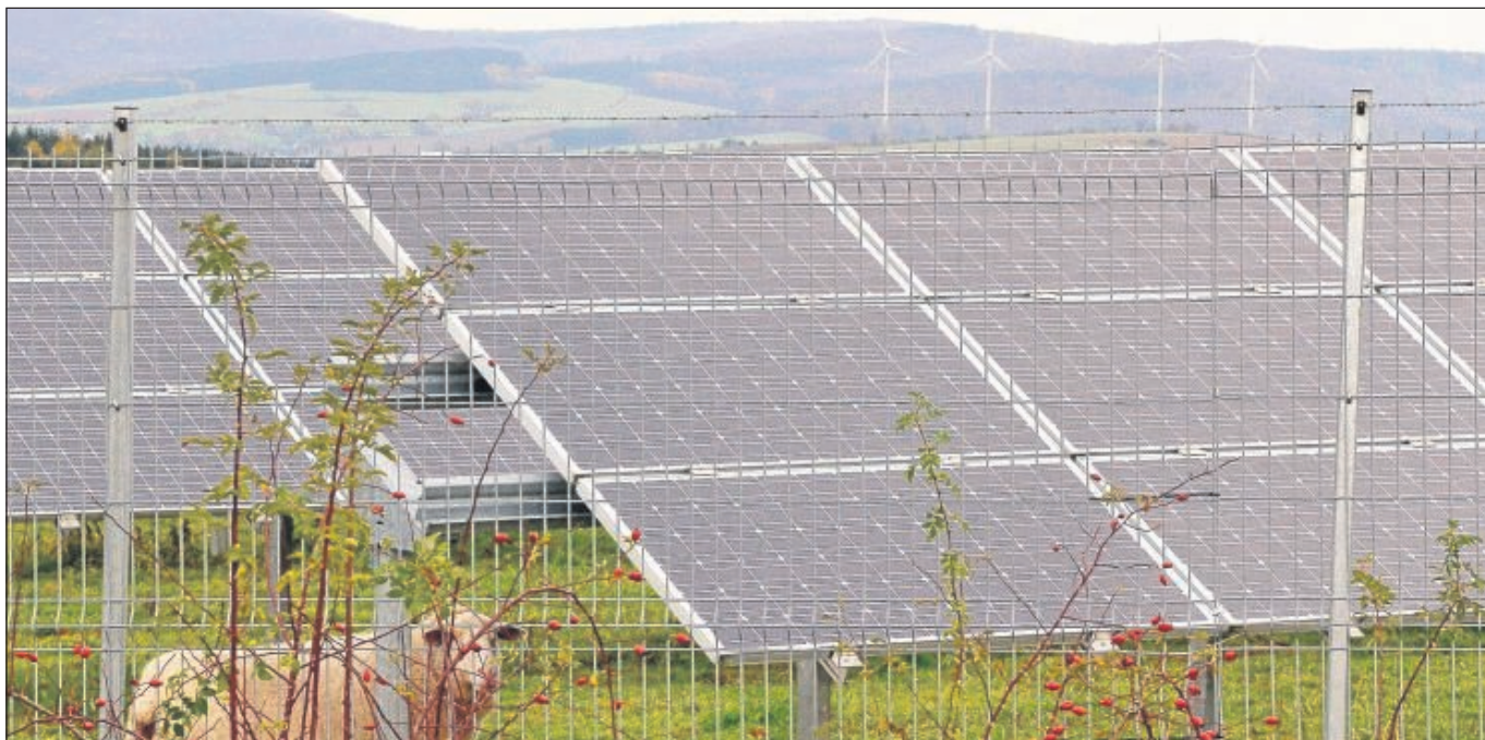
Photovoltaik und Windkraft: Im Uslarer Land gehören nach Einschätzung von Experten Windräder und Voltaikanlagen zu den Energiequellen, die es ermöglichen können, die deutschlandweite Energiewende umzusetzen.
