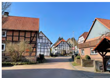
Rehbachstraße, Blick nach Süden
