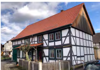
Sichtmauerwerk mit Putzgefachen, Giebelbekleidung aus Holz
