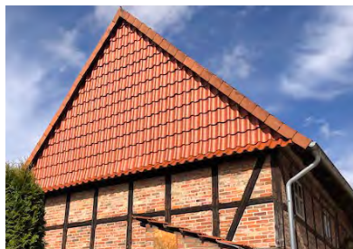
Sichtfachwerk mit Ziegelausfachung Giebelbekleidung mit Ziegeln
