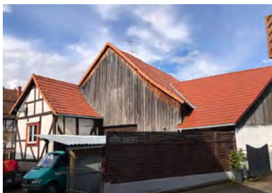
Satteldächer mit roten Tondachziegeln
