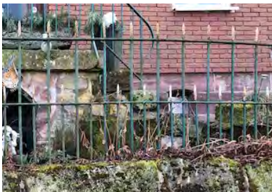
Natursteinsockel mit Metallgeländer
