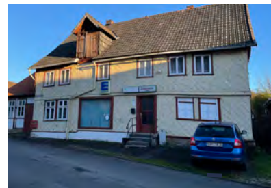
Mit Blechschindeln bekleidetes Fach- werkgebäude
