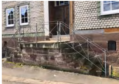
Zweihüftiger Treppenaufgang aus Sandstein mit Metallgeländer
