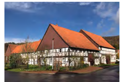
Satteldächer mit roten Tondachziegeln
