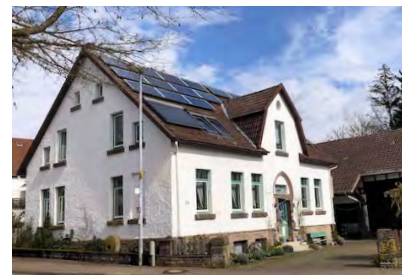
Gebäude in massiver Bauweise
