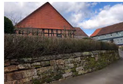
Sandsteinmauer mit Heckenpflanzung
