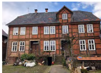
Walmdach mit dunklen Tondachziegeln
